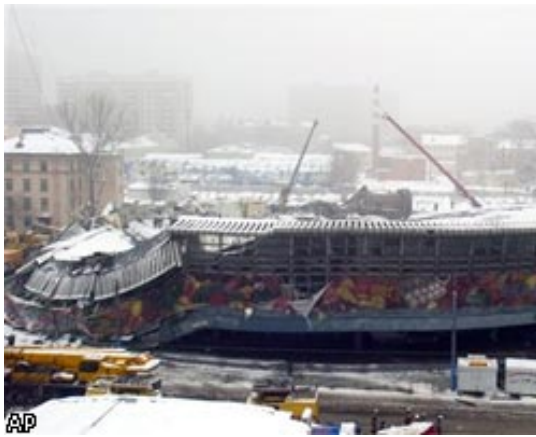
Обрушение здания Басманного рынка в Москве
