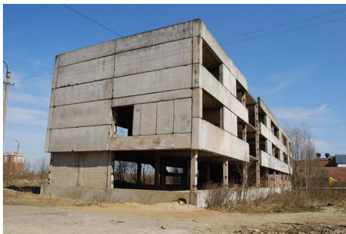
Рисунок 1. Вид на здание снаружи
