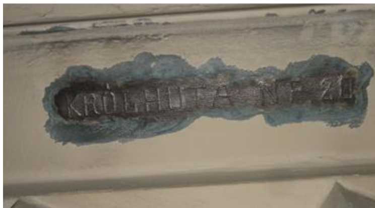
Рисунок 8. Клеймо на косоуре лестничного марша
