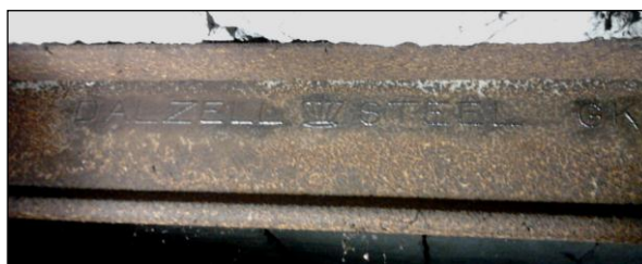
Рисунок 6. Вид балки ассиметричного С-образного профиля с клеймом
