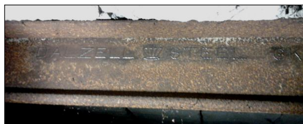
Рисунок 6. Вид балки ассиметричного С-образного профиля с клеймом
