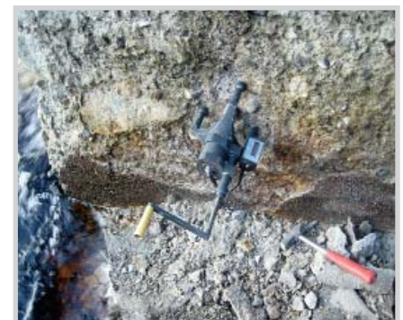
Рис. 3. Испытание бетона методом отрыва со скалыванием
