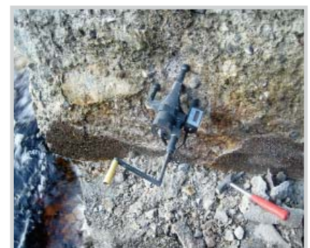
Рис. 3. Испытание бетона методом отрыва со скалыванием
