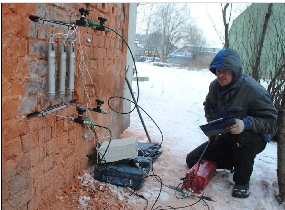
Рисунок 3 - Испытание кладки методом плоских домкратов
