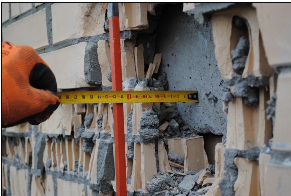
**Рисунок 8 – Раздробление кладки в уровне перекрытия**
