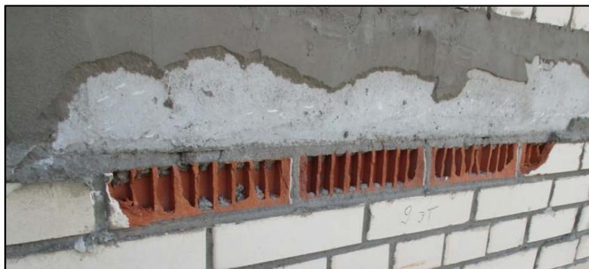
**Рисунок 3 – Раздробление кладки под перекрытием**
