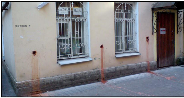
Рисунок 4. Участки отбора проб из стен здания по адресу: Невский пр. д.136
