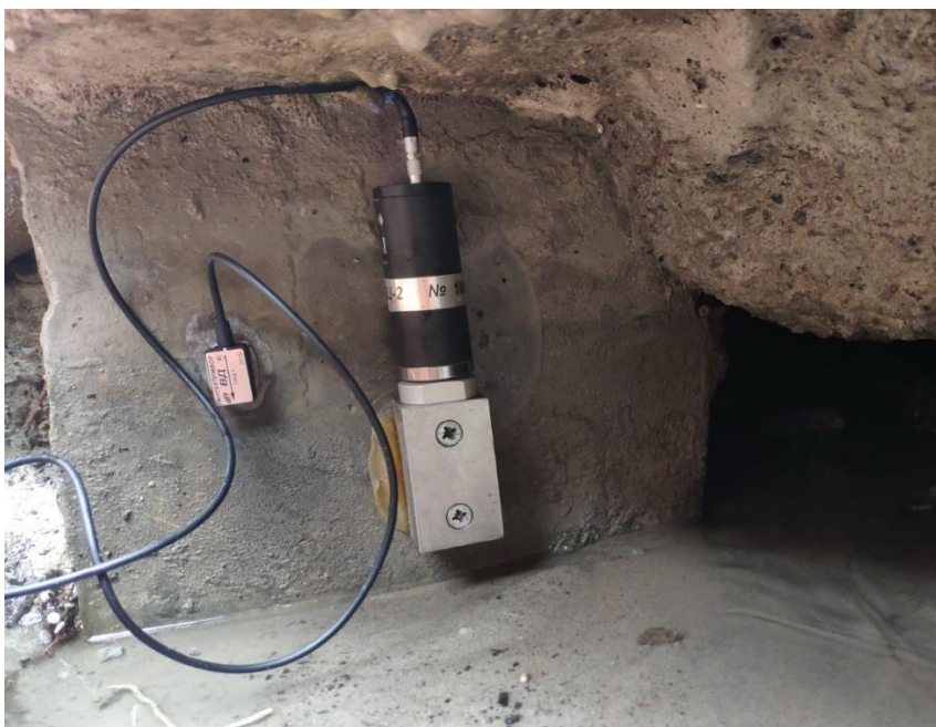
Рисунок 5 - Два датчика, установленные на свае под ростверком: на консоль (справа) и непосредственно на боковую поверхность сваи (слева).
